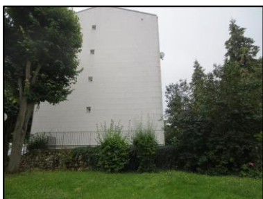
Photo N° 1123 ECH-N°02 --facades Murs bardages sur pignons
